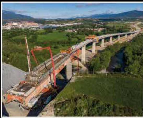
Autovía A-23, Huesca
