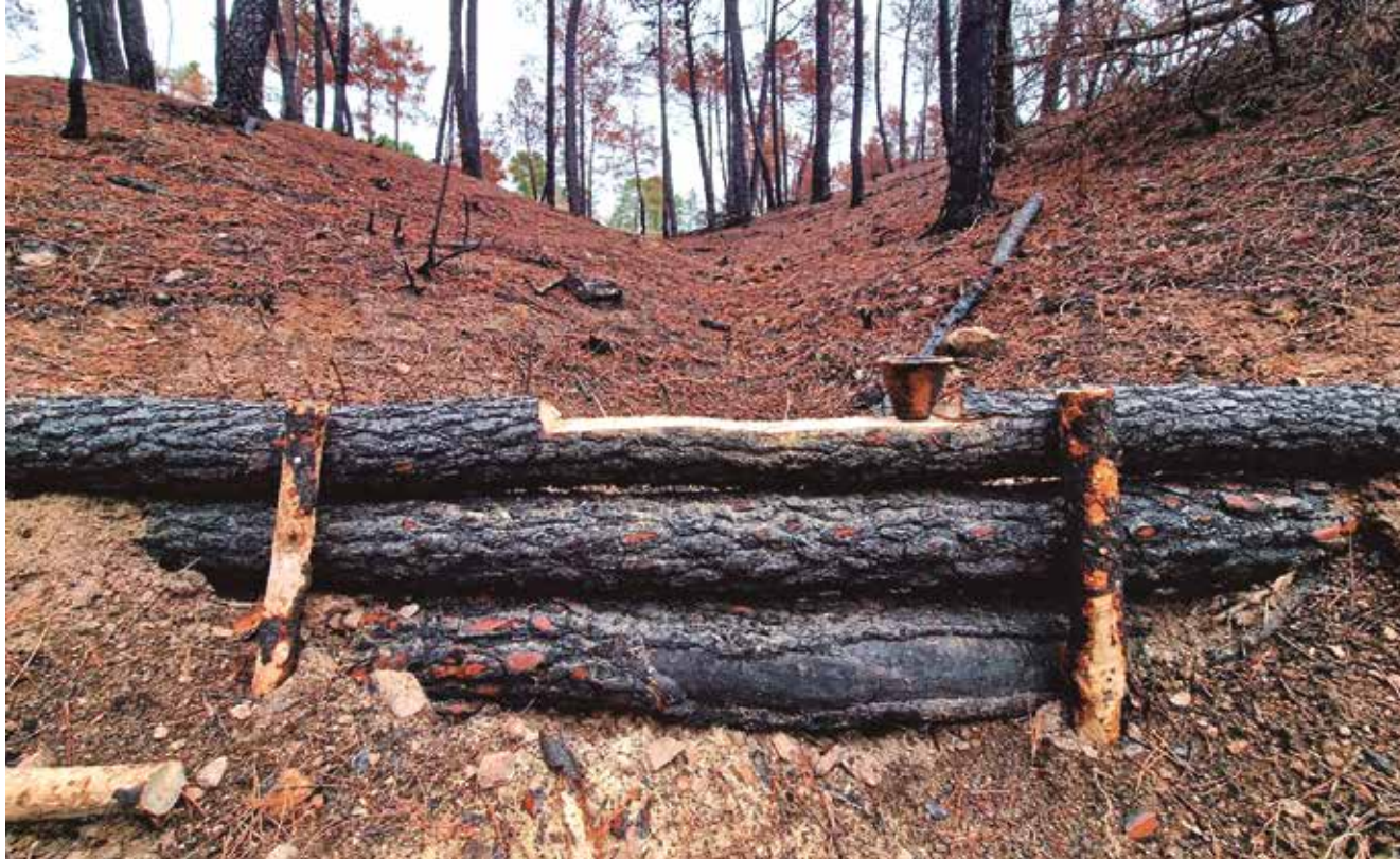
Fajinas ejecutadas en las zonas con mayor pendiente e intensidad de fuego, con el fin de proteger el suelo de la escorrentía superficial.
