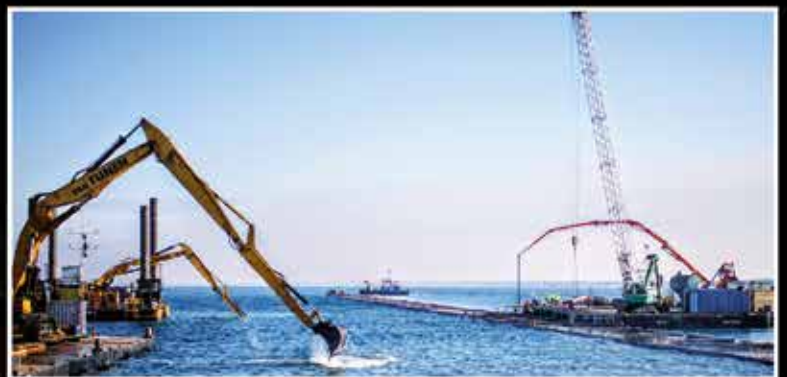
Diques en Gdansk, Polonia
